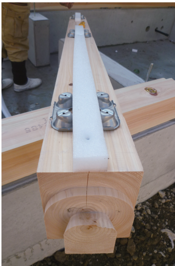
ダイカラットと通気止めシートを使った施工例（大阪府池田市）
