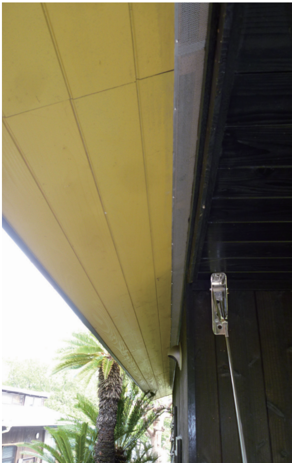
軒天通風材 施工例 (神戸市須磨区)
