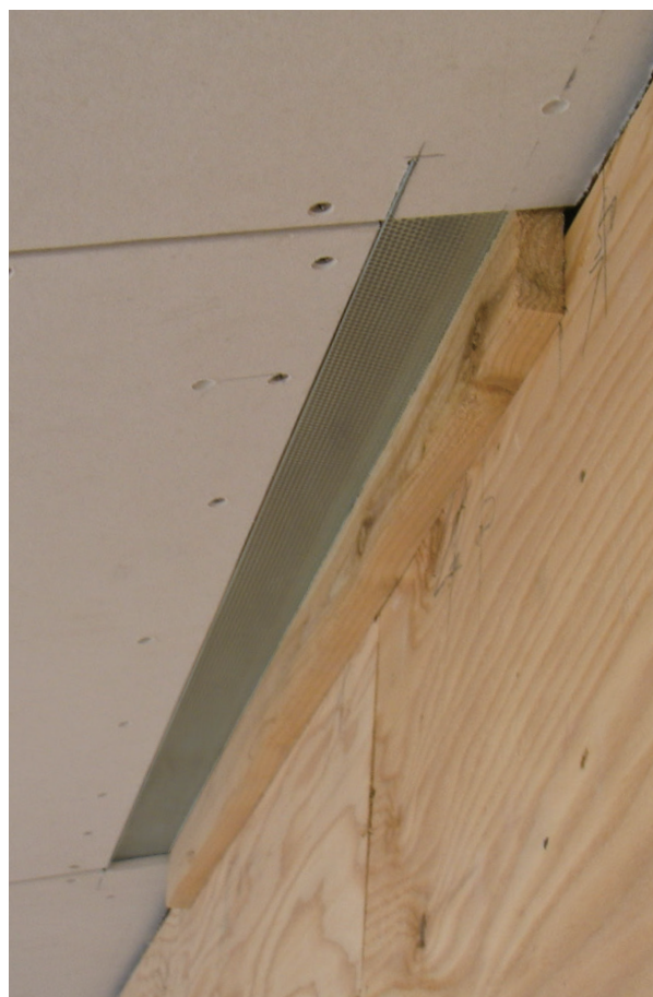
軒天通風材 施工例 (愛知県知多市)
