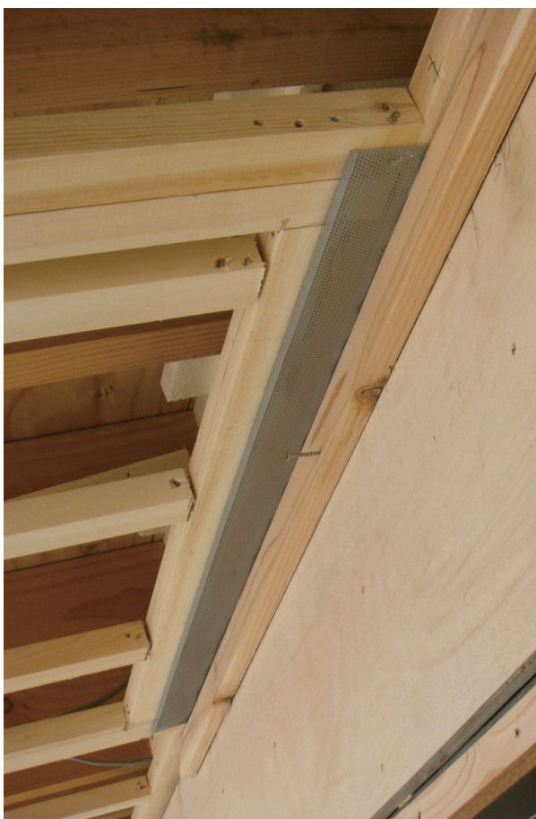
軒天通風材 施工例 (愛知県知多市)
