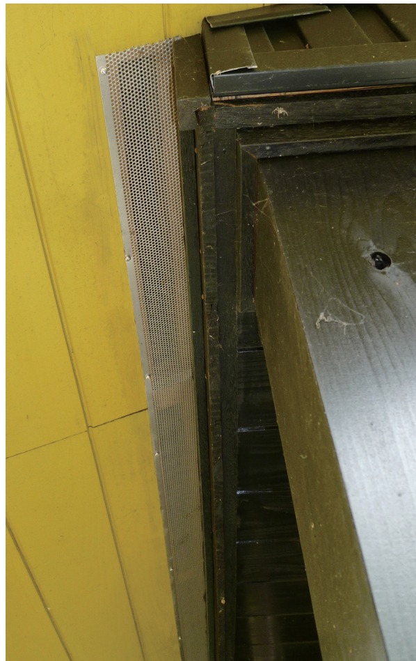
軒天通風材 施工例 (神戸市須磨区)
