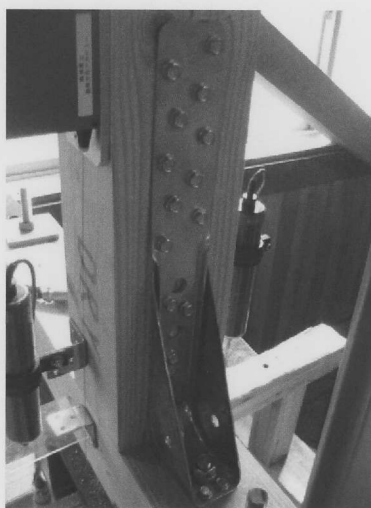
写真 2.1.1 コボット補強版
