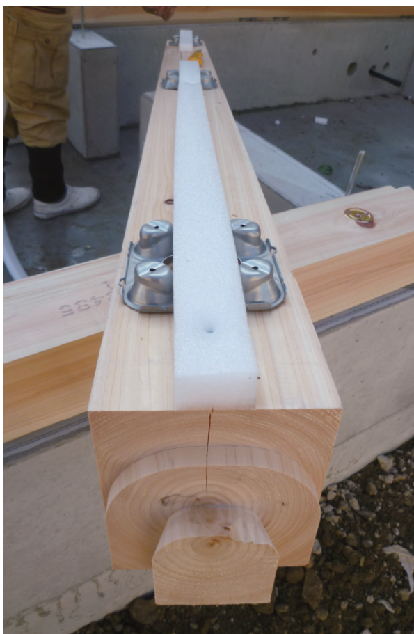
ダイカラットと通気止めシートを使った施工例 (大阪府池田市)
