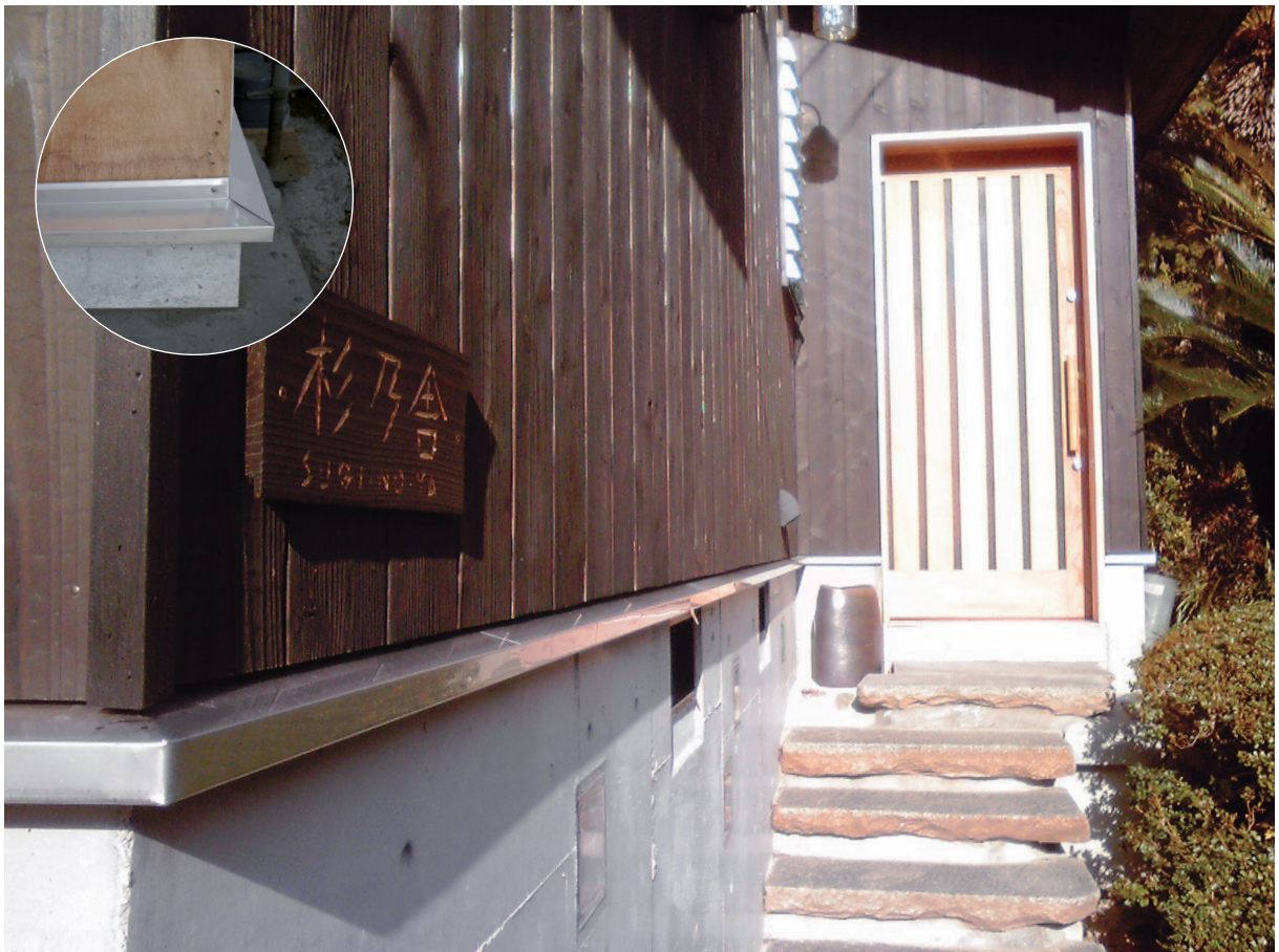
水切り材 施工例（神戸市須磨区）
