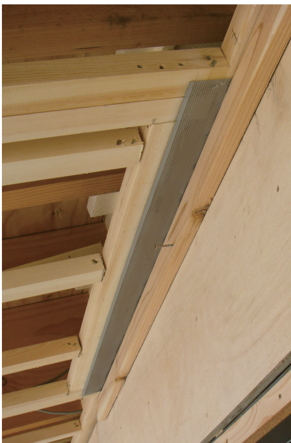
軒天通風材 施工例 (愛知県知多市)
