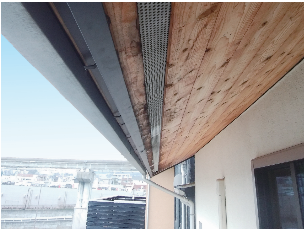
軒天通風材 施工例 (神奈川県茅ヶ崎市)
