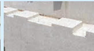
養生後ガイドを外せば、それぞれのスリットマンにピッタリの幅と深さの凹みが完成
