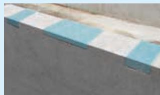
コンクリート打設時に、ガイドのスタイロを予定位置の基礎の上に埋め込む
