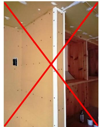
・合板等は施工時にアクが出てくる可能性がありますので、下地が必要な場所には M クロス（紙付ベニヤ板）を使用する事をお勧めします。（カット面が露出する場合、シーラー処理が必要です。）
