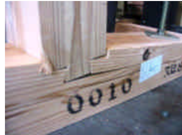
写真 4.3.4 下部材の割れ（最大変形時）
