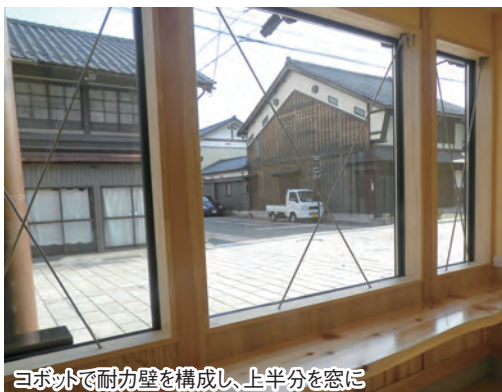
長屋改修工事で壁にせずブレースで耐力壁に
