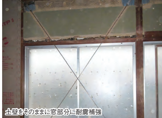
一般住宅の増改築時に土壁を崩すことなく耐震補強
