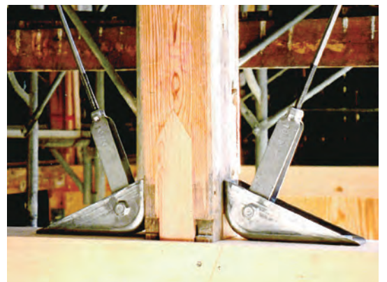
コボット本体を、連続する壁と共に「ヨコ使い」で設置した施工例
