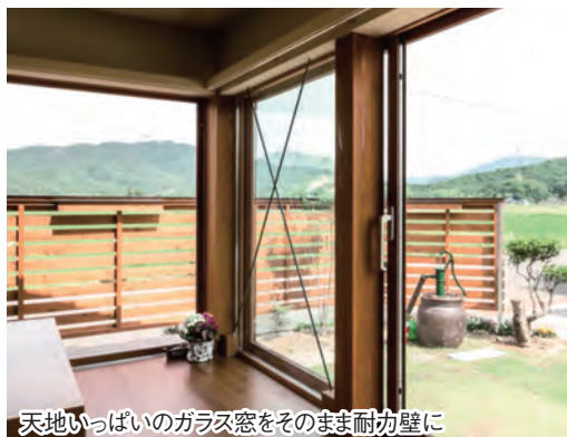
外壁一面のガラス窓をシースルーのまま補強
