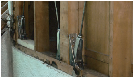
外壁からブレースを張ったリフォーム施工例(大阪市城東区)
