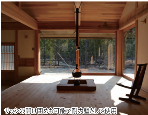
全面ガラスの大壁面を生かしたまま耐力壁に
