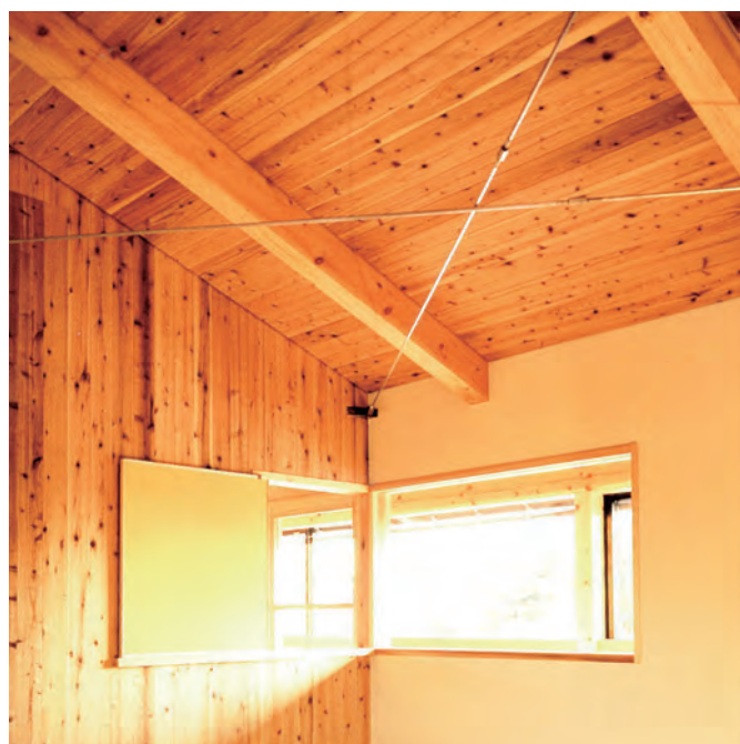
一般住宅の吹き抜け水平面補強(岩手県奥州市)
