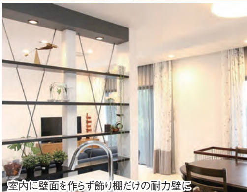
コボットで耐力壁を構成し、上半分を窓に
