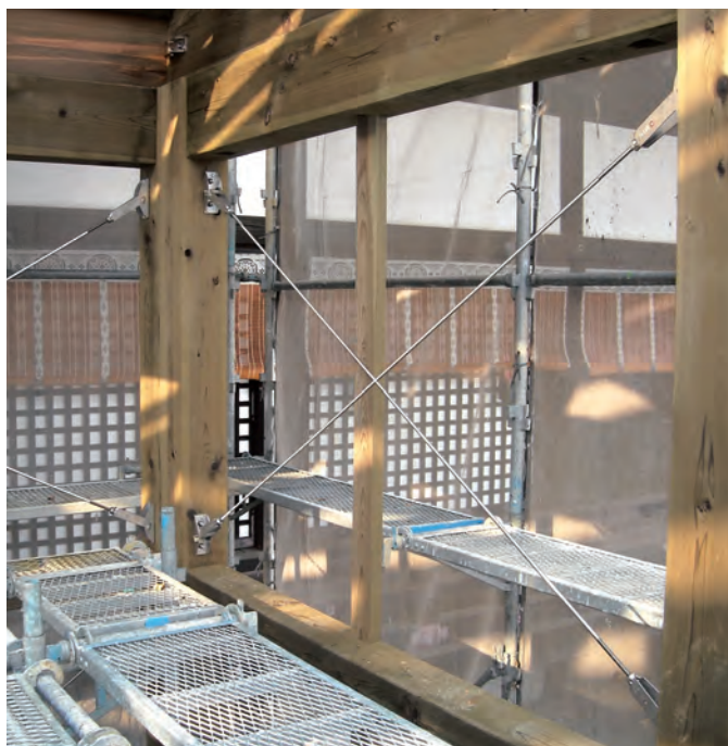
京都御所「紫宸殿(ししんでん)」右近の橋の防寒建屋での採用例(京都市上京区)
