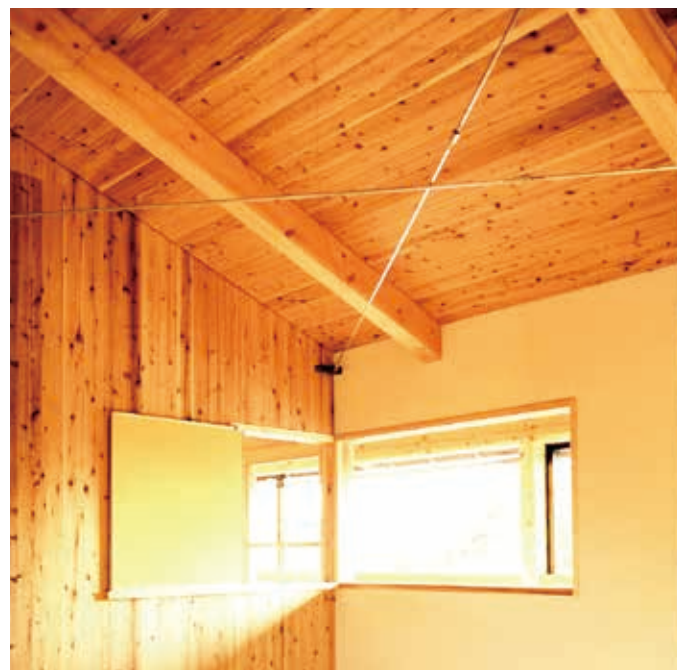
一般住宅の吹き抜け水平面補強(岩手県奥州市)
