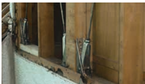
外壁からプレスを張ったリフォーム施工例(大阪府城東区)
