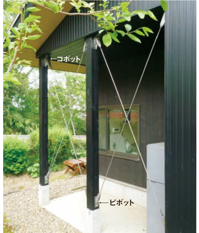
一般住宅・下にピボット、上にコボットでブレースを張った施工例(神戸市須磨区)
