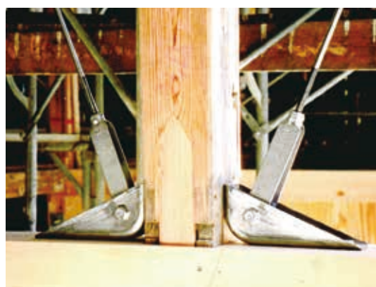
コボット本体を、連続する壁と共に「ヨコ使い」で設置した施工例
