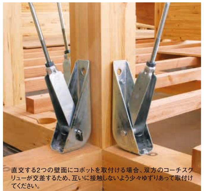
新築住宅の耐震補強例(兵庫県西宮市)
