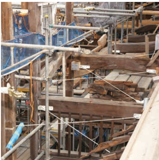
指定文化財・旧諸戸家住宅御殿の耐震改修工事(三重県桑名市)
