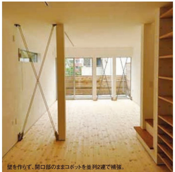
コボット本体を横に2台並べてセットできる幅さえあれば設置可能。
