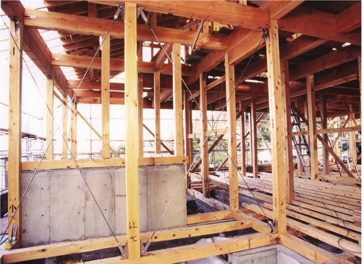
新築住宅の耐震補強例(兵庫県西宮市)
