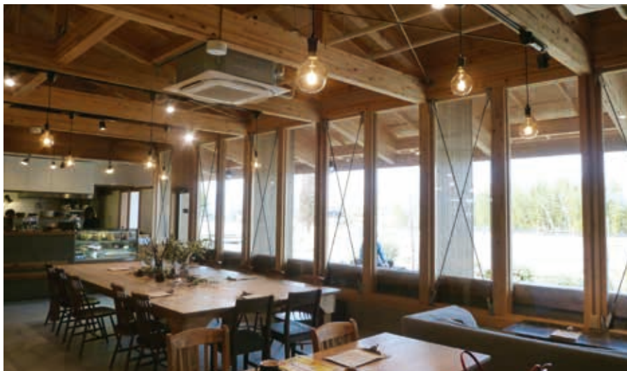
開放感あるカフェでの壁面および水平面の耐震補強例(「fai彩ひろば」・滋賀県草津市)
