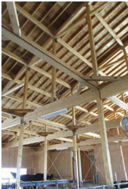
木造牛舎での耐震補強(北海道釧路市)
