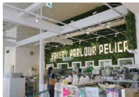
コーヒーショップの水平面補強を白色塗装で(愛知県蟹江市)
