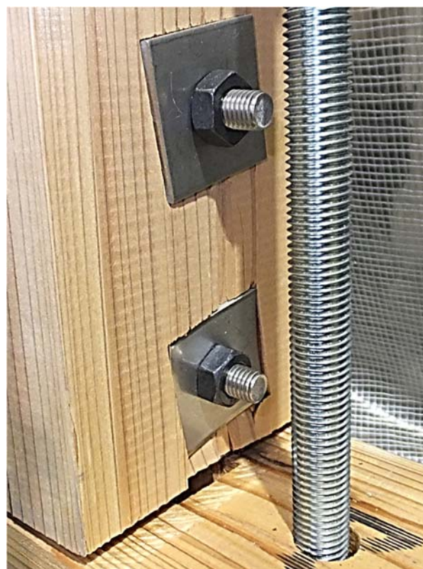
4. 柱脚部破壊状況 (角座金側)
