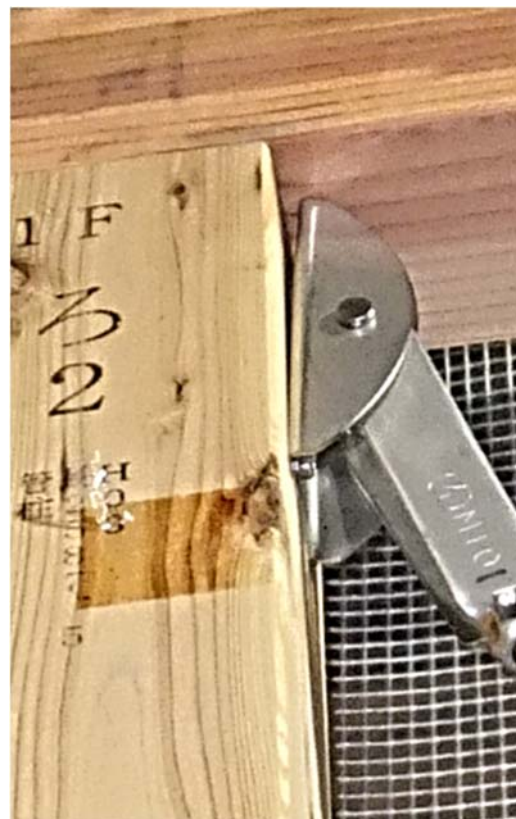
4. 柱頭部破壊状況
