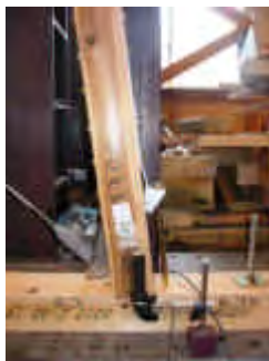
写真 4.5.3 右下接合部（最大変形時）
