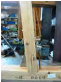
写真 4.3.3 右下接合部（最大変形時）
