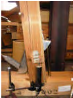
写真 4.7.3 右下接合部（最大変形時）
