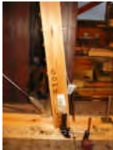
写真 4.6.3 右下接合部（最大変形時）
